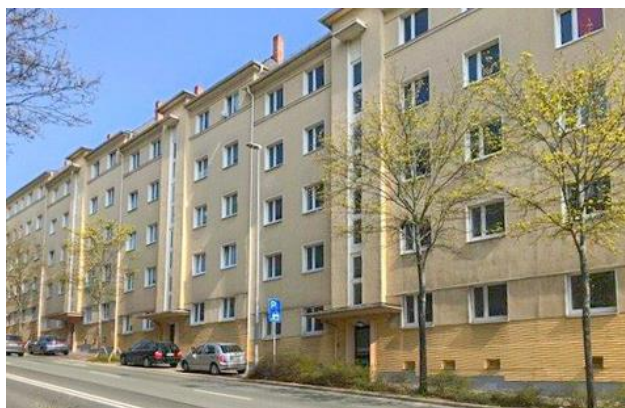
Bild 01: In der Martin-Luther-Straße warten großzügig geschnittene 2-bis 6-Raum-Wohnungen auf neue Mieter*innen. Foto: TAG Wohnen
